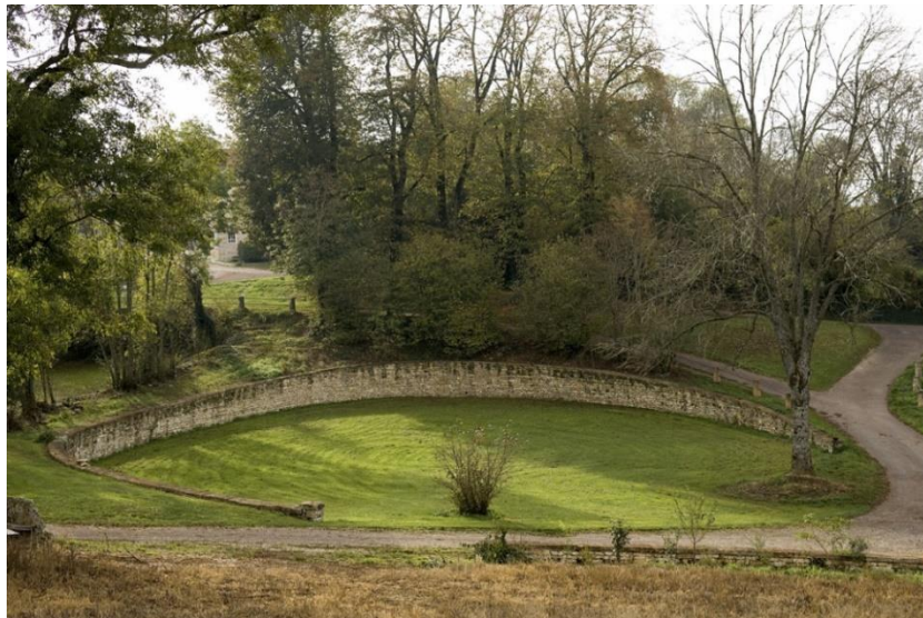
Figure 3 Vue de la cour faisant face au lavoir rénové de Blessey. Disponible à cette adresse : Le lavoir de Blessey | Les Nouveaux commanditaires
